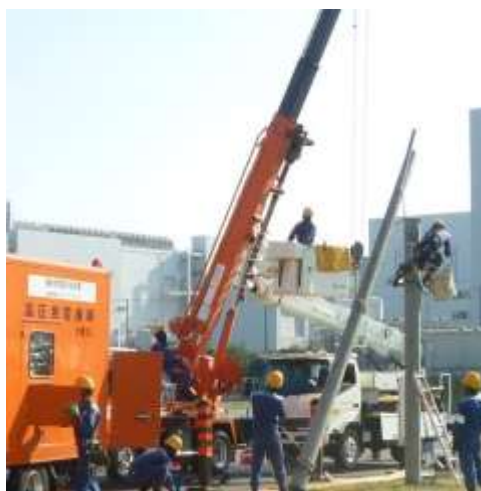
電力設備復旧
