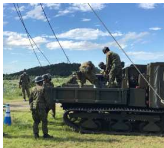
不整地運搬車による変圧器運搬
