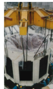
■同期調相機写真（固定子吊込み）
