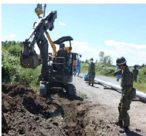
電柱建て込み場所の掘削作業
