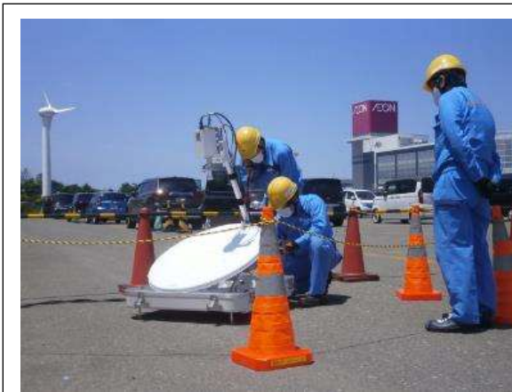
衛星回線を活用した通信回線設置
