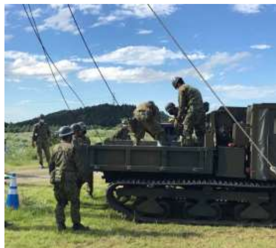
不整地運搬車による変圧器運搬
