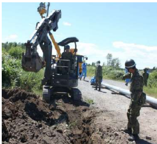
電柱建て込み場所の掘削作業
