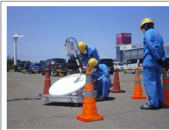
衛星回線を活用した通信回線設置
