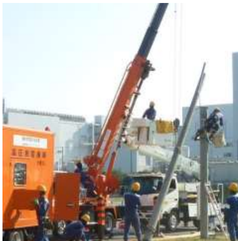
電力設備復旧
