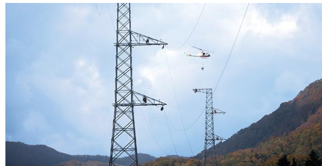
新北本ルート 直流送電線（架空部）
