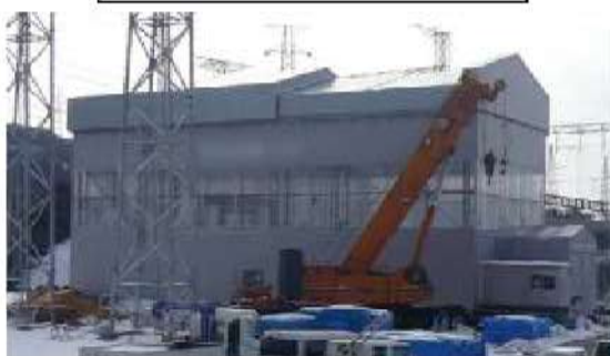
変圧器組立用防塵ハウス
