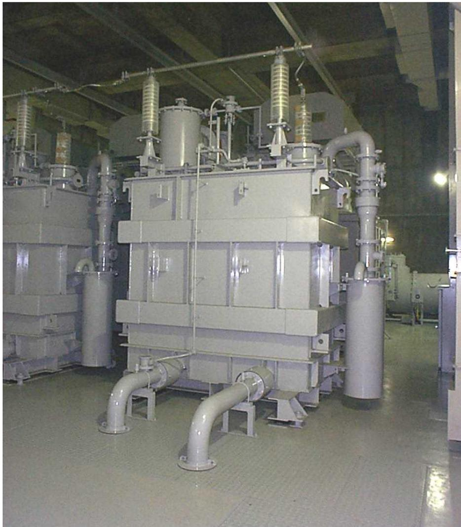
サイリスタバルブから発生する高調波を吸収し、電力系統に流出しないようにする装置です。
