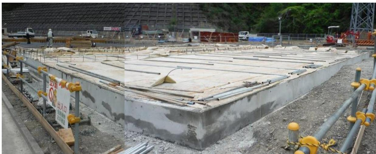
ガス絶縁開閉装置基礎 コンクリート打設後
