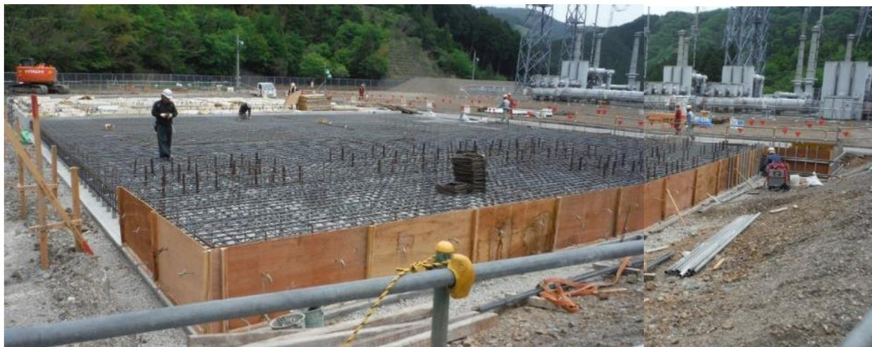
ガス絶縁開閉装置基礎 鉄筋型枠組立中
