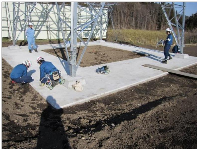
使用前検査（基礎寸法検査）
