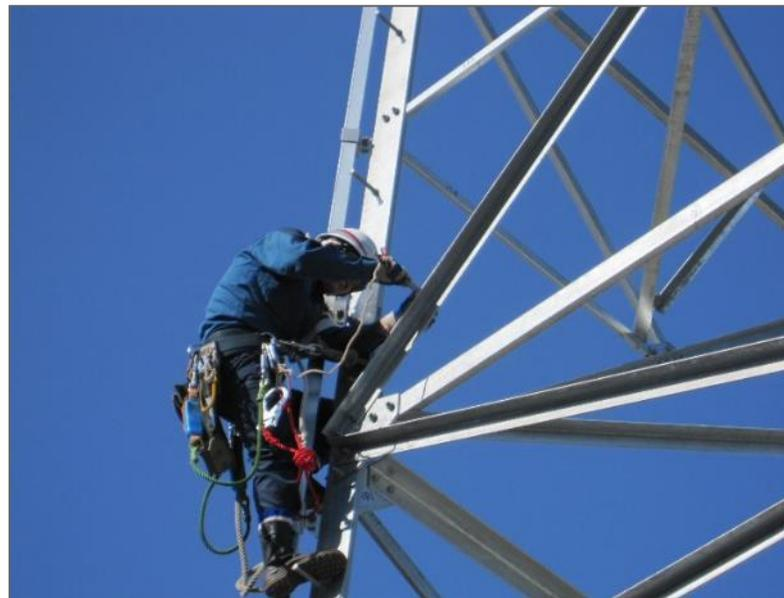
使用前検査（鉄塔寸法検査）
