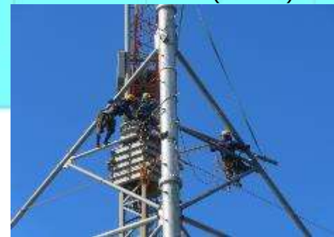
F. 鉄塔組立工事(No.165)
