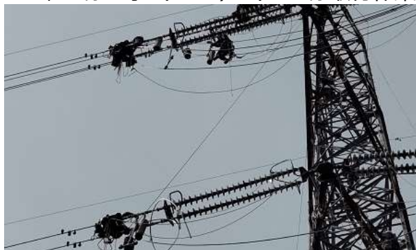
C. 架空線工事 (No.55) (J P 線取付作業)
