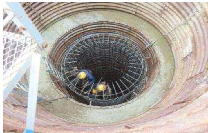
B. 鉄塔基礎工事 (常磐北幹線No.154)
