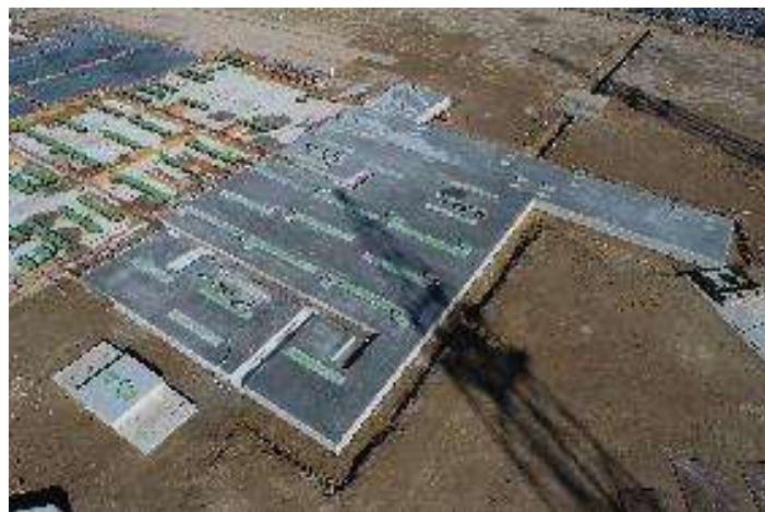
GIS二次コンクリート (1, 3/5ブロック)
