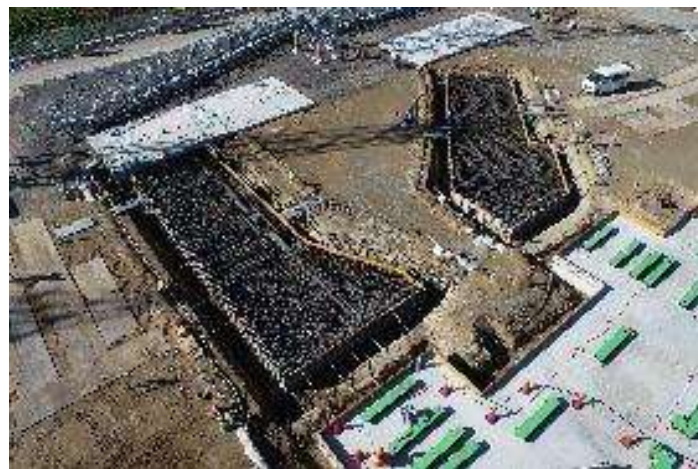
中間支持基礎打設前 (2/4基)
