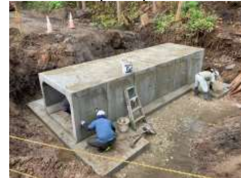
C. 造成工事(No.76)
