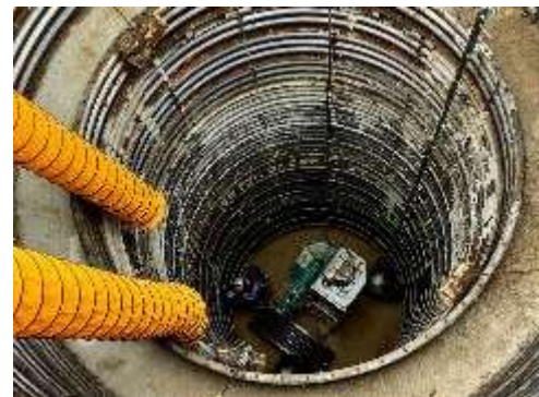
C. 鉄塔基礎工事 (No.71)
