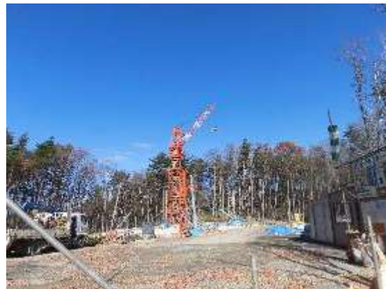
B. 鉄塔組立工事 (No.63)
