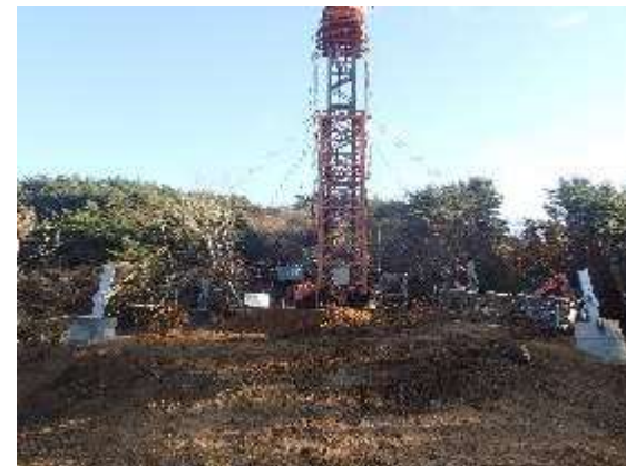
C. 鉄塔組立工事 (No.77)
