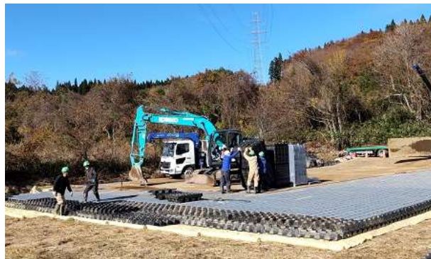
B. 架空線工事 (No.92) (延線作業)
