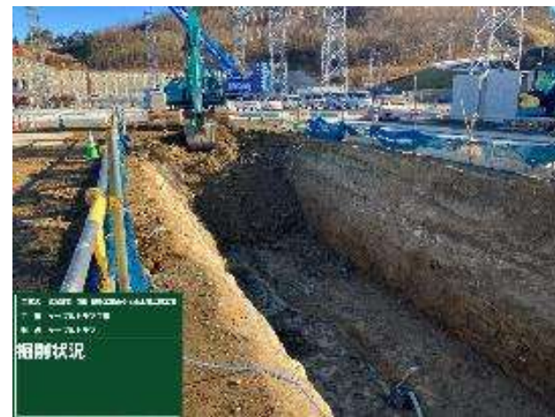
ケーブルダクト部掘削
