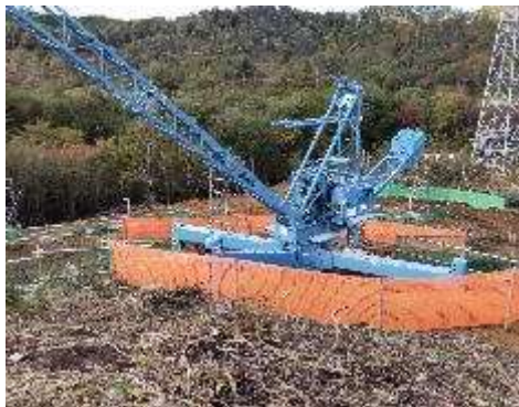
B. 鉄塔基礎工事 (No.53)
