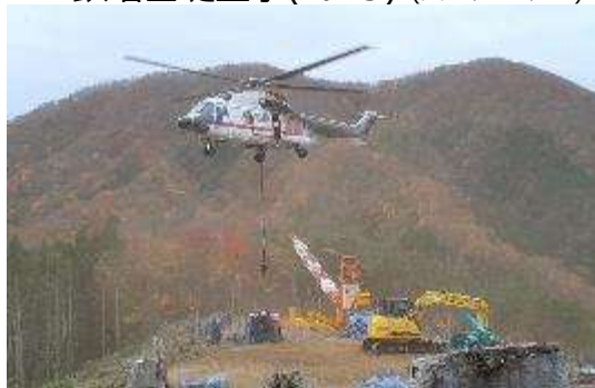
B. 鉄塔基礎工事(No.45) (資機材ヘリ物輸)
