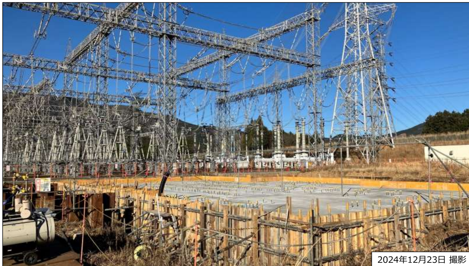
変圧器基礎 一次コン打設完了
