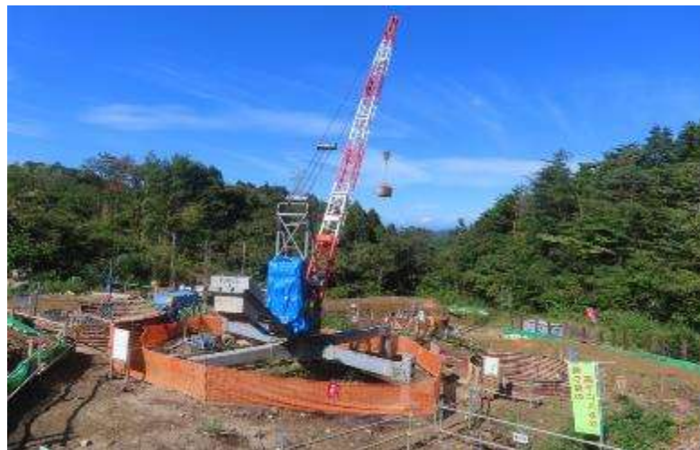
A. 鉄塔基礎工事 (常磐北幹線No.155)
