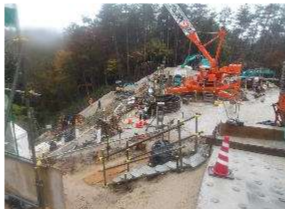
A. 鉄塔基礎工事 (No.58)
