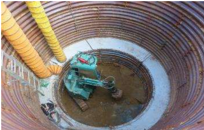
A. 基礎工事 (常磐北幹線No.154)
