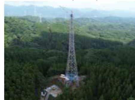
C. 鉄塔組立工事(No.76)
