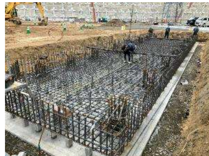
中間支持 鉄筋組立
