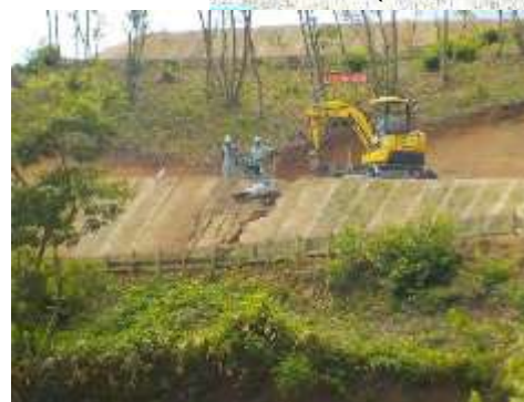
F. 造成工事 (No.136) (台風被害補修)
