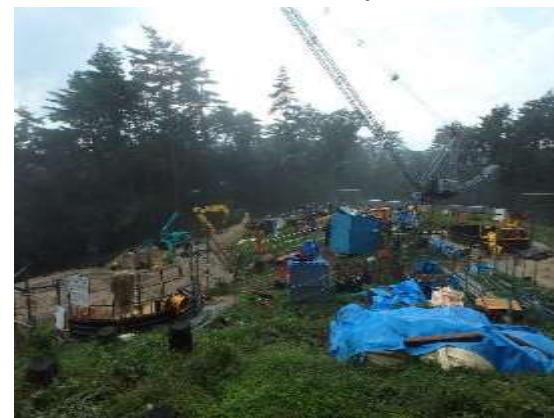
C. 鉄塔基礎工事 (No.78)
