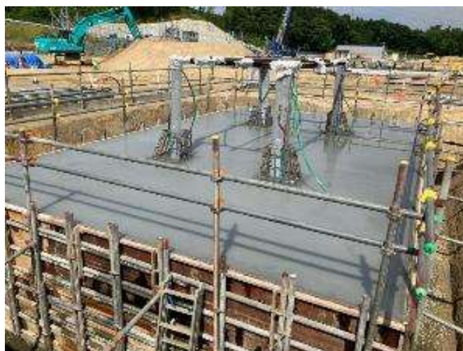
鉄構基礎打設
