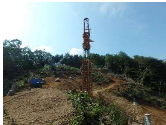
B. 鉄塔組立工事 (No.71)
