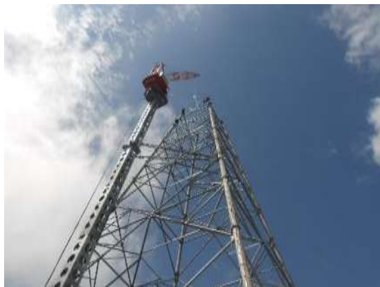
A. 鉄塔組立工事 (No.70)
