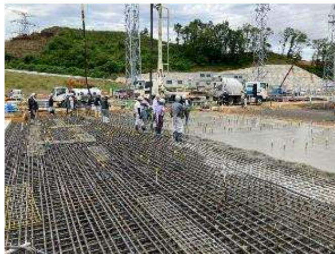
GIS基礎2/5ブロック打設
