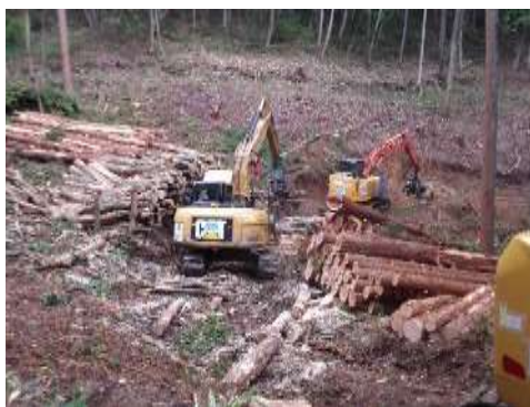
B. 伐採工事 (No.57)
