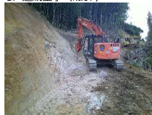
C. 造成工事 (No.67)
