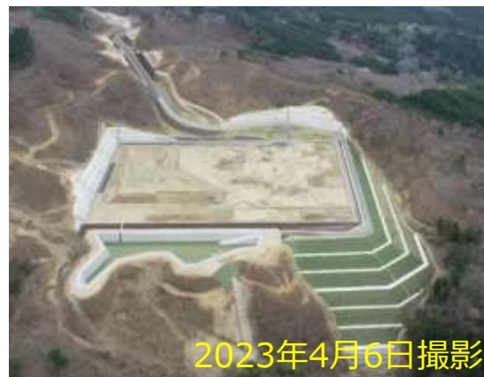
全景（北側より撮影）
