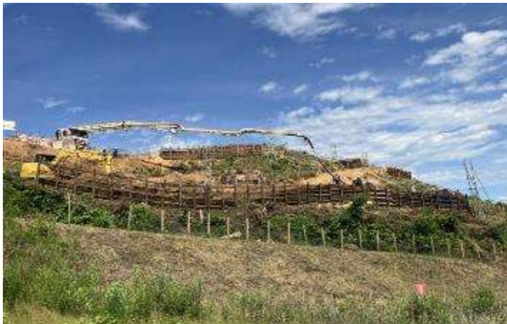
B. 基礎工事 (常磐南幹線No.1)
