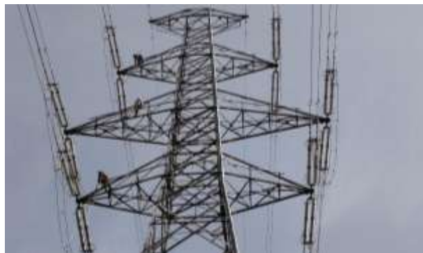
C. 架線工事 (No.92) (電線延線)
