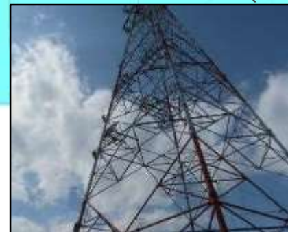
F. 航空障害灯設置工事(No.170)
