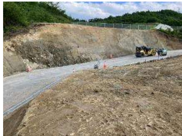
B. 造成工事 (常磐北幹線No.155)
