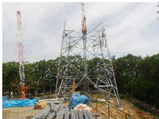
A. 鉄塔組立工事 (No.69)
