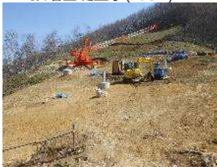
B. 鉄塔基礎工事(No.52)
