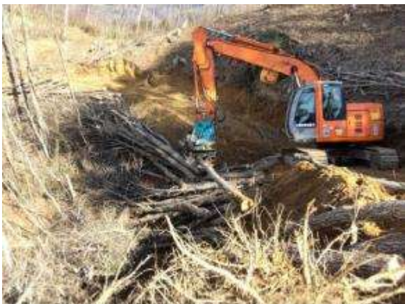
A. 伐採工事 (常磐北幹線No.155)
