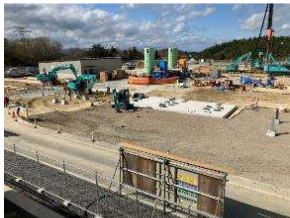
南側基礎周り路盤構築 (機器据付重機乗入れ用)
