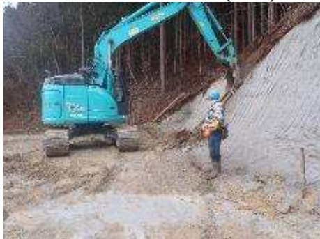
A. 仮設道路造成工事(No.1)
