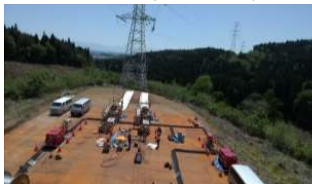
C. 架線工事 (No.92) (電線延線)
