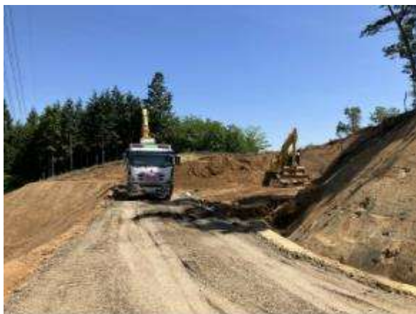
C. 造成工事 (常磐南幹線No. 1)
