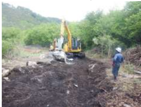
B. 造成工事 (No.53)
