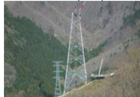
C. 鉄塔組立工事(No.59)
