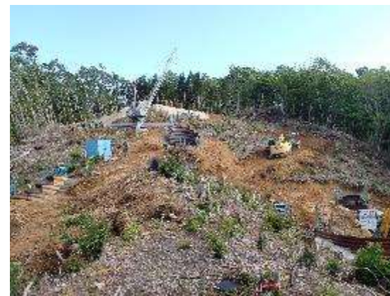
C. 鉄塔基礎工事 (No.71)
