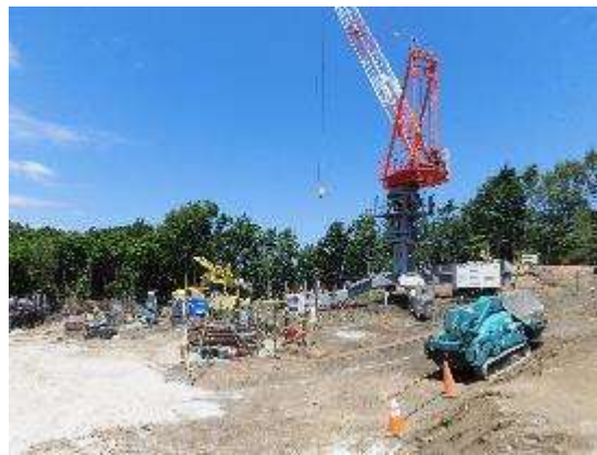
B. 鉄塔基礎工事 (No.70)
