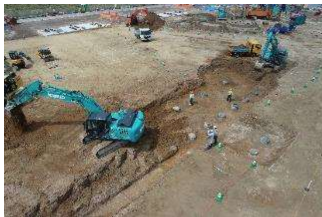
GIS基礎掘削
