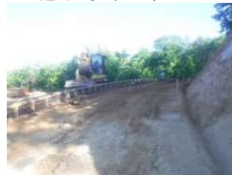
C. 造成工事 (No.71)
