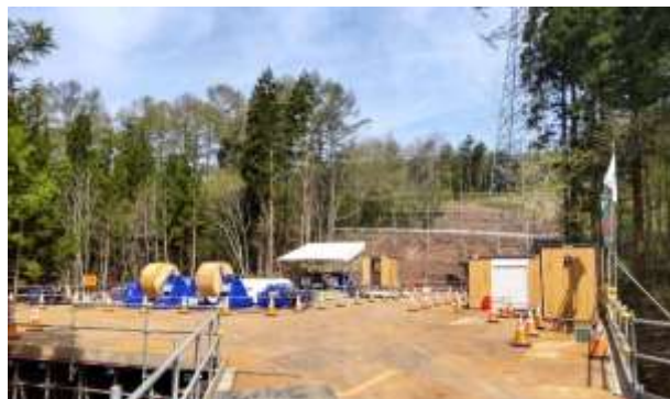
B. 架線工事 (No.71) (乙接地付け)
