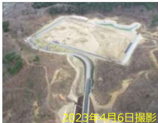
全景（南側より撮影）
