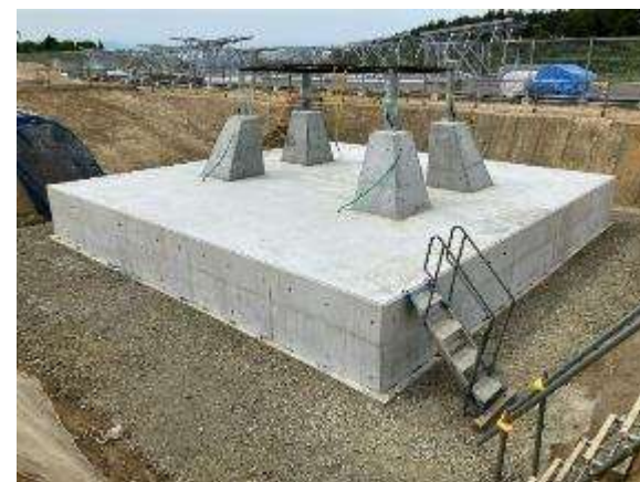
鉄構基礎PD6(直接基礎) 完成
