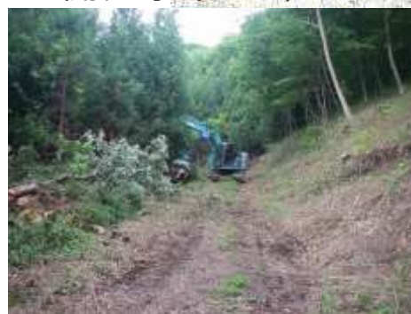
F. 伐採工事 (No.144)
