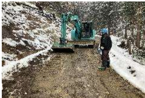
A. 仮設道路造成(No.19)
