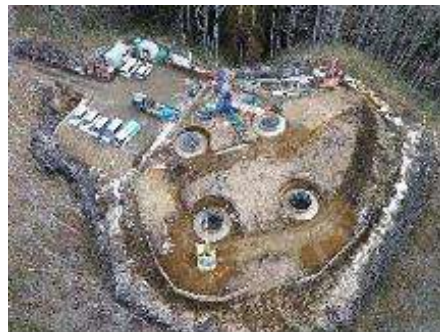
B. 鉄塔基礎工事(No.68)
