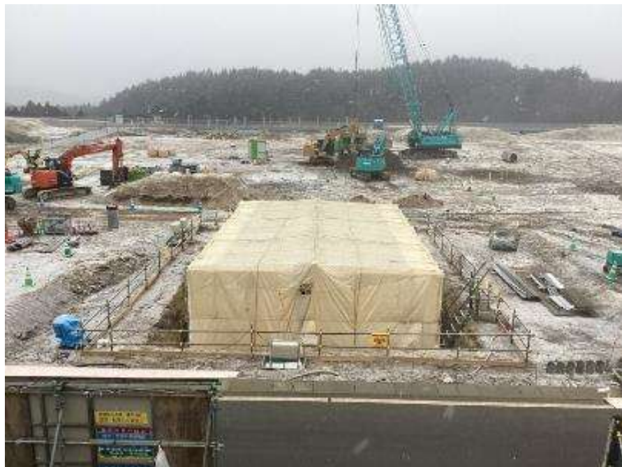
鉄構基礎寒中養生状況（2024年2月）
