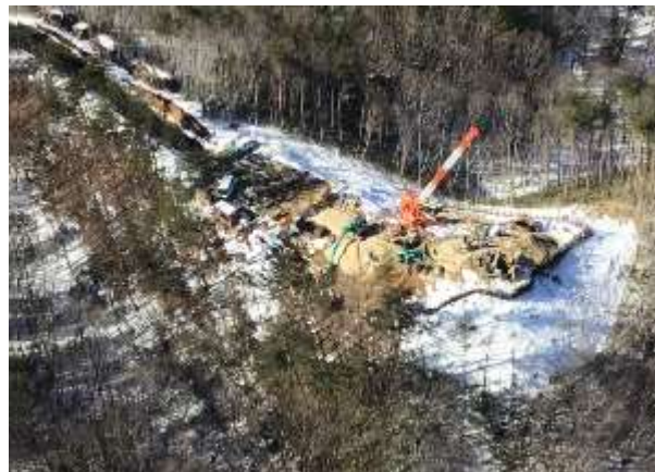
B. 鉄塔基礎工事 (No.68)
