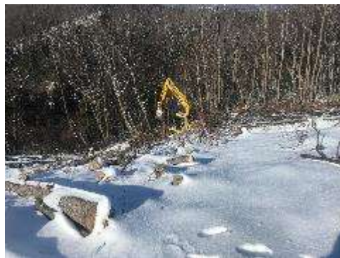
B. 伐採工事 (No.64)
