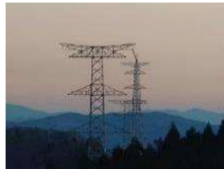
D. 鉄塔組立工事(No.102)
