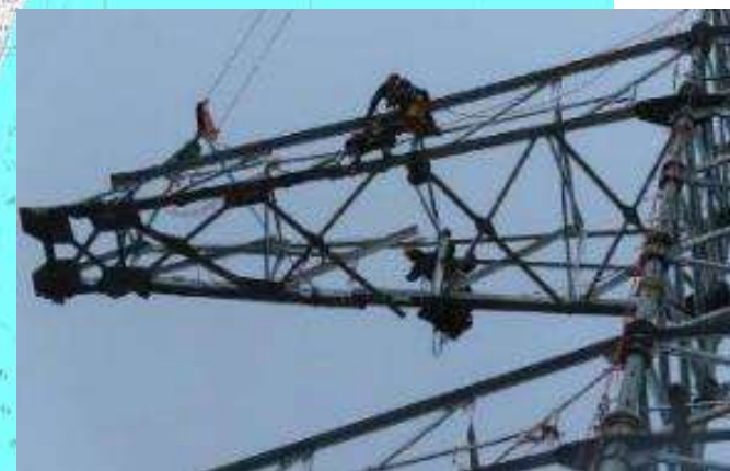
F. 鉄塔組立工事(No.168)
