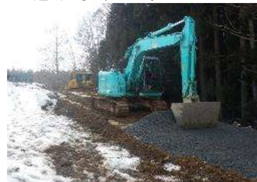
D. 造成工事 (No.104)
