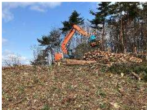
A. 伐採工事 (No.13)
