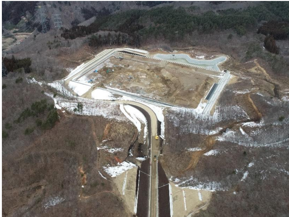
全景 (南側より撮影)
