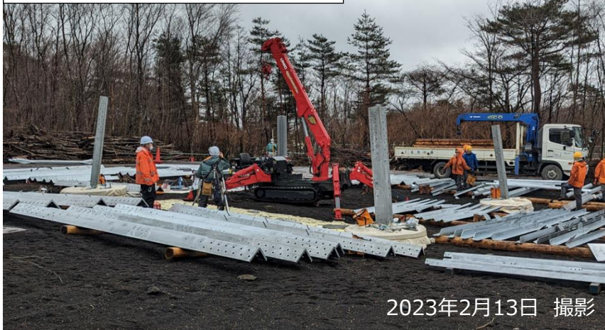
鉄塔組立(12工区)
