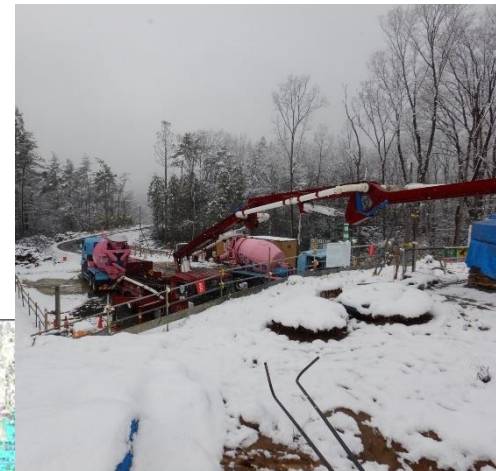
C. 基礎工事
