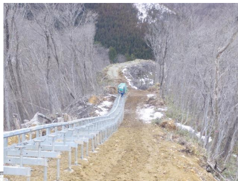
B. 仮設造成工事
