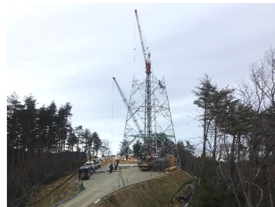
C. 鉄塔組立工事
