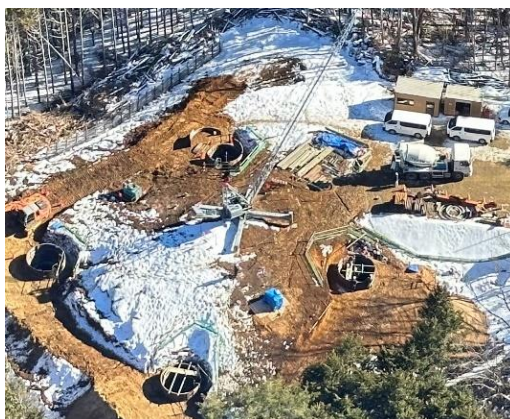
B. 鉄塔基礎工事
