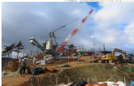
E. 基礎工事
