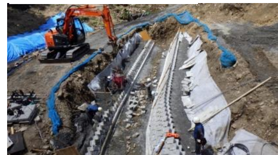
撮影①改修水路末端部
