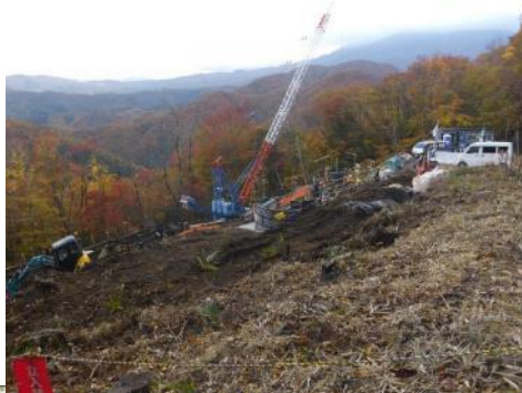
B. 基礎工事
