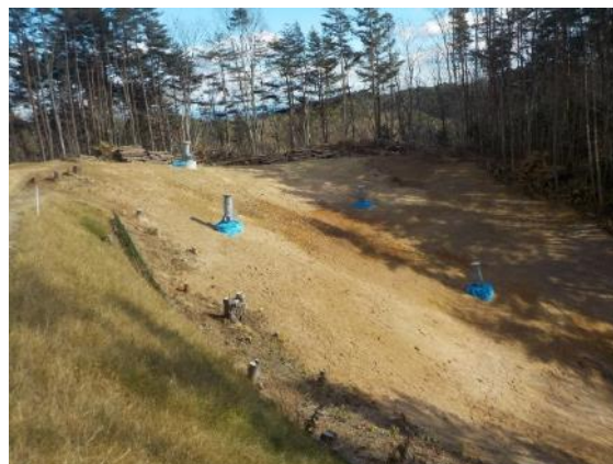
B. 鉄塔基礎工事
