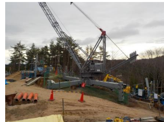
C. 鉄塔基礎工事
