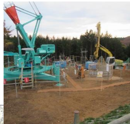
C. 基礎工事
