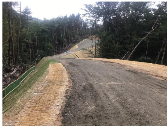
C. 仮設道路造成工事
