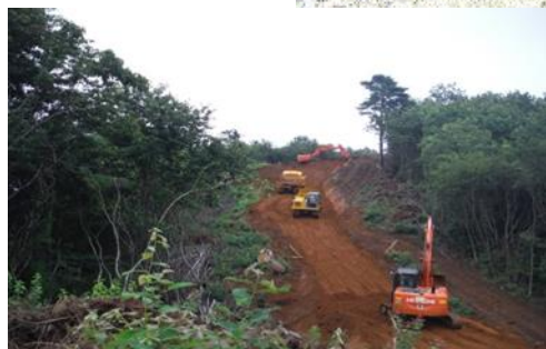
E. 仮設道路造成工
