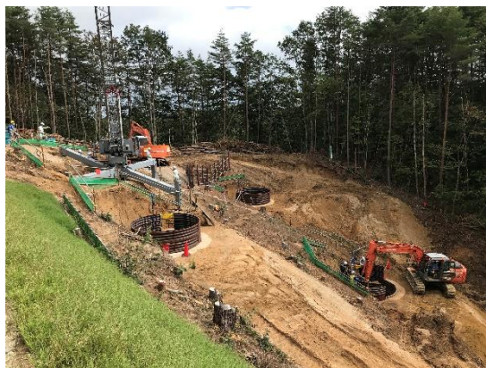
B. 鉄塔基礎工事
