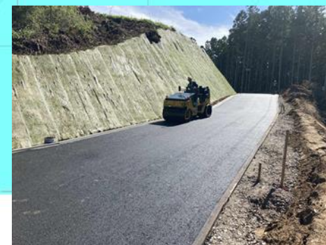
F. 造成工事
