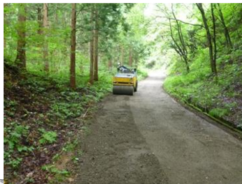
B. 仮設道路造成工事
