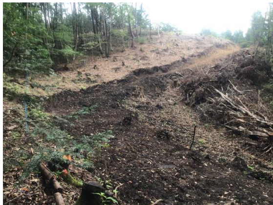
A. 伐採工事
