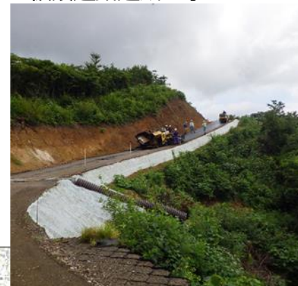
C. 仮設道路造成工事
