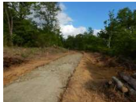
C. 仮設道路造成工事
