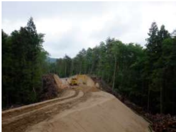
A. 仮設道路造成工事
