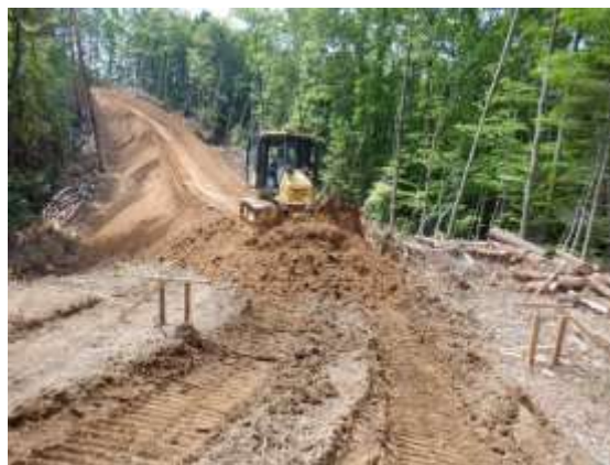
B. 仮設道路造成工事
