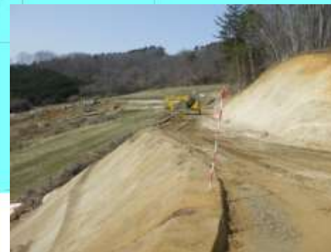
F. 仮設道路造成工事
