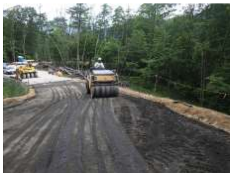
B. 仮設道路造成工事
