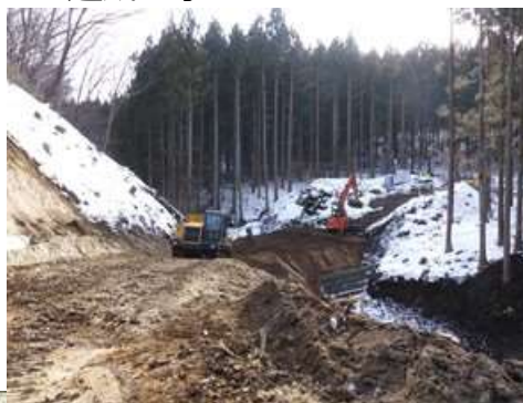
B. 造成工事
