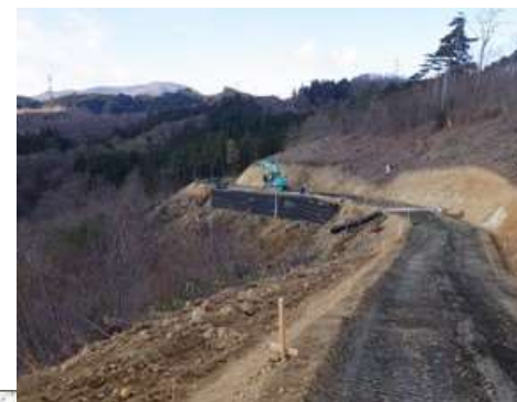
C. 造成工事
