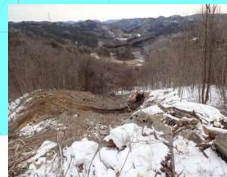
F. 造成工事
