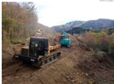
④造成工事
