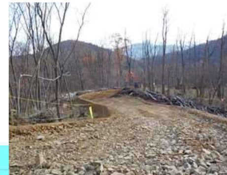
③造成工事
