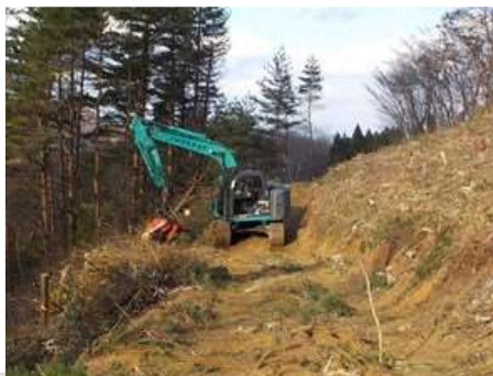
②伐採工事
