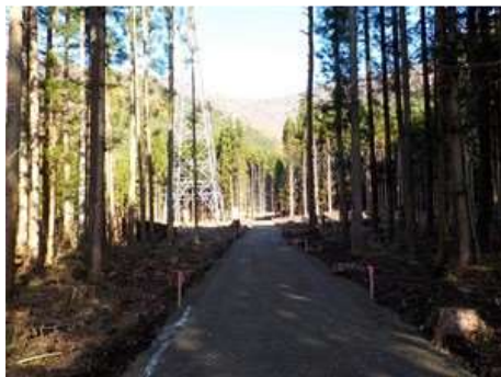
①造成工事
