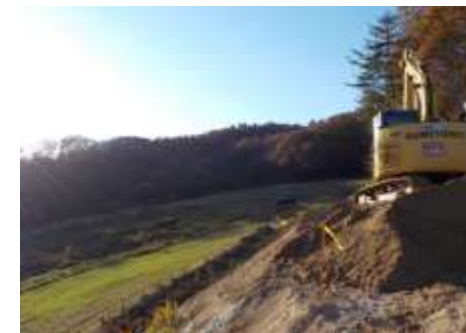
⑤造成工事
