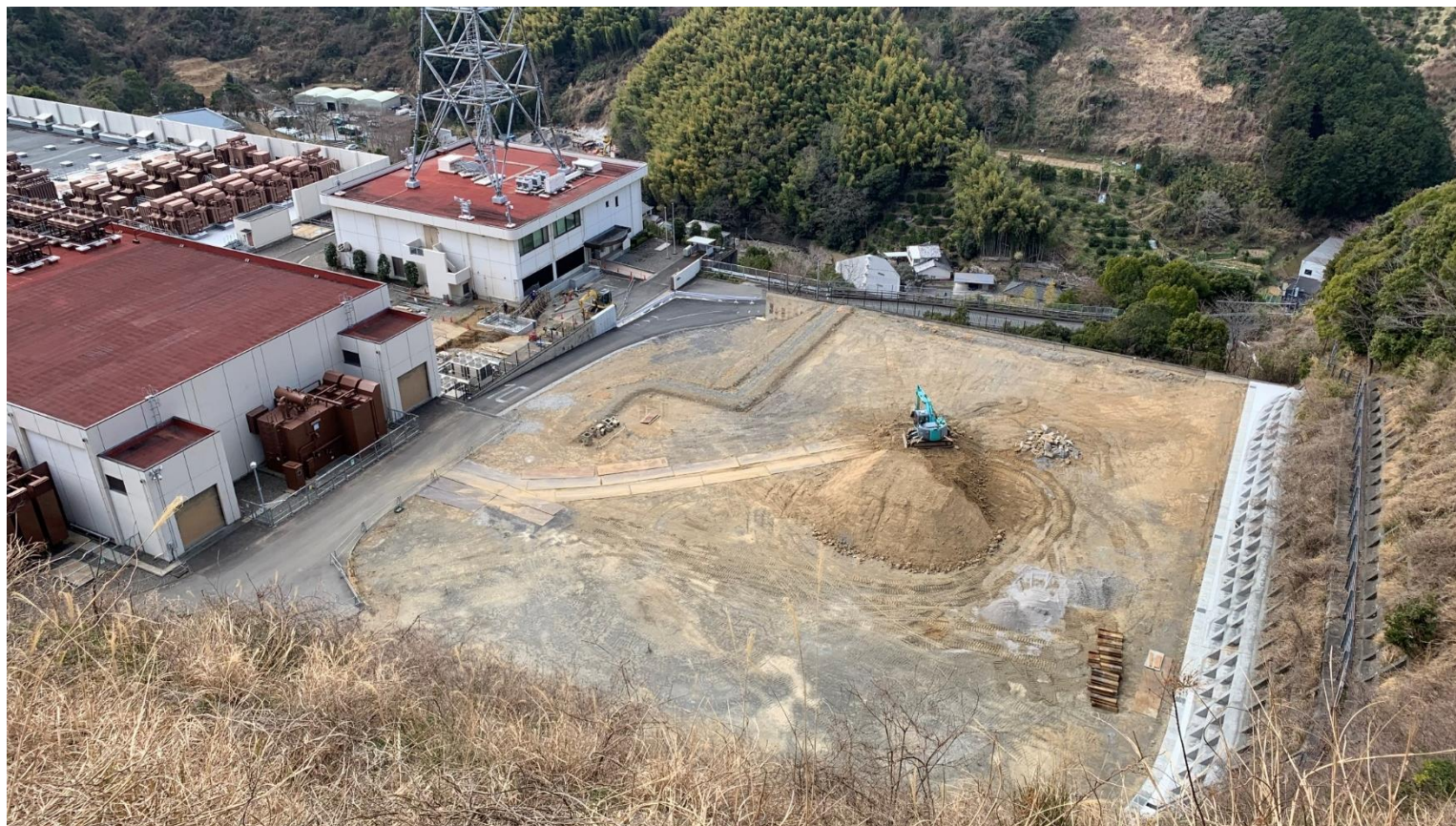
東清水変電所FC増設 工事状況 (2021年3月1日撮影)
