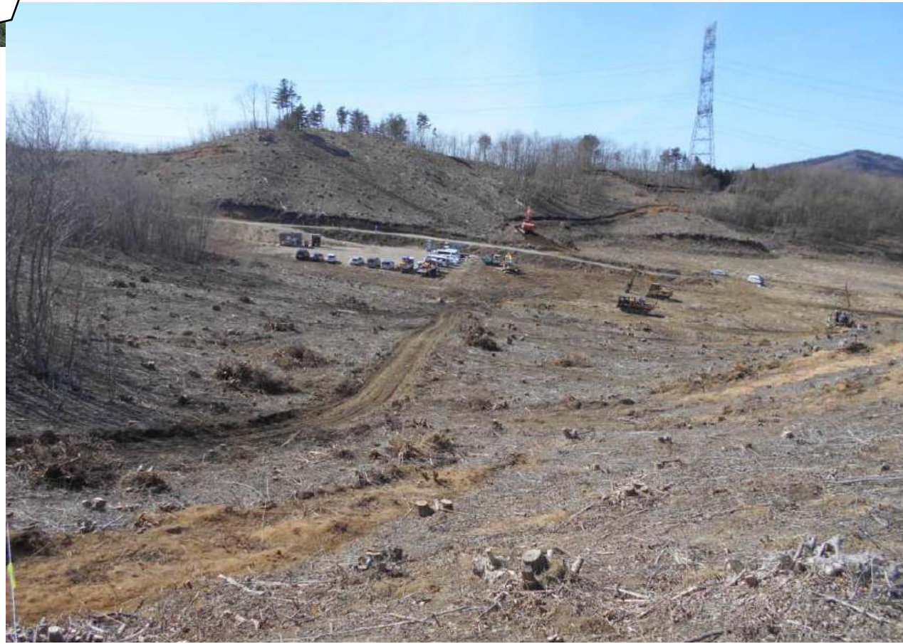
広域連系開閉所の敷地造成工事の状況（2021年3月9日撮影）
