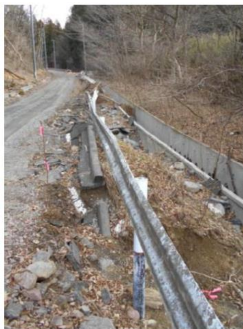
林道ガードレール損壊・法面流出
