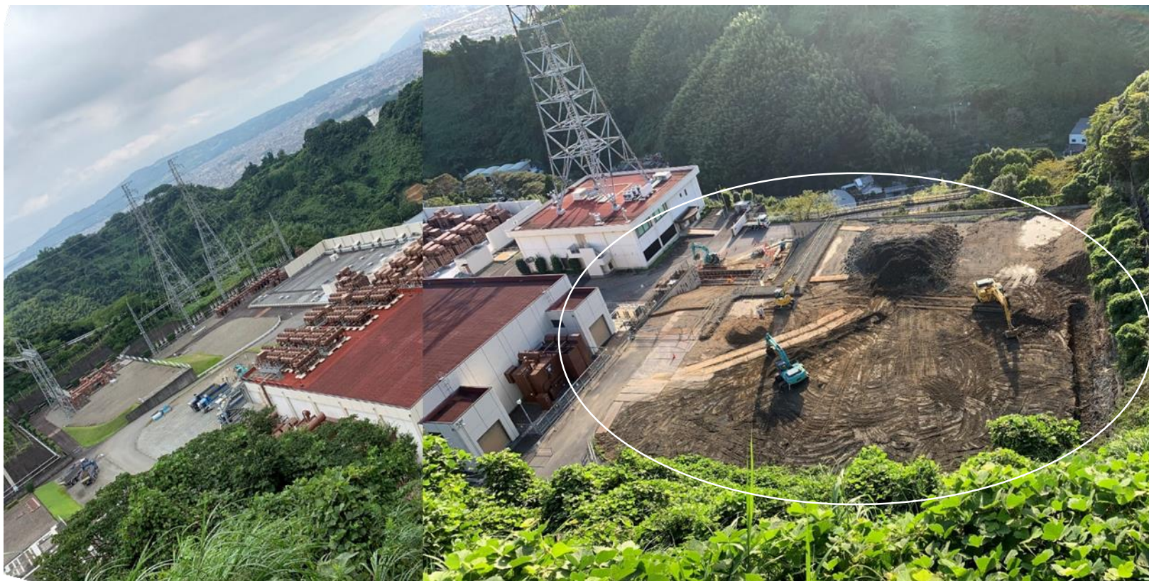
東清水FC増強工事の状況
