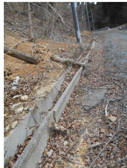
林道路盤流出
