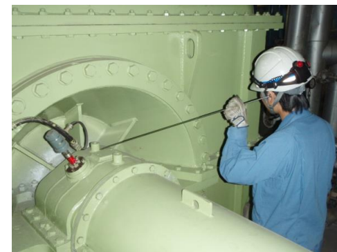
現場でのパトロール状況
