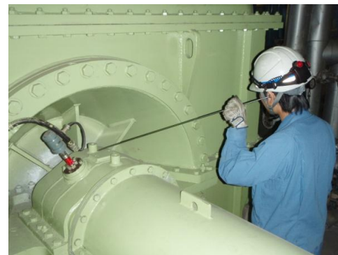
現場でのパトロール状況
