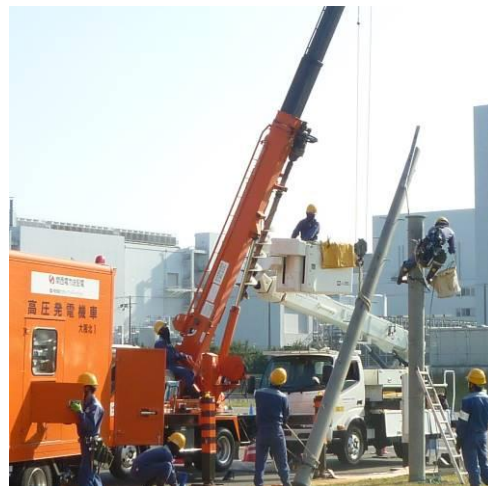
電力設備復旧
