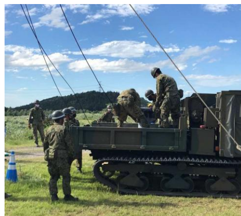
不整地運搬車による変圧器運搬
