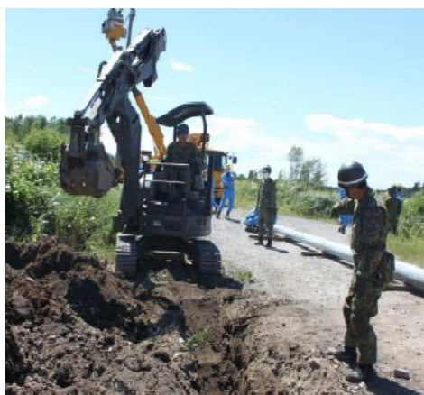
電柱建て込み場所の掘削作業
