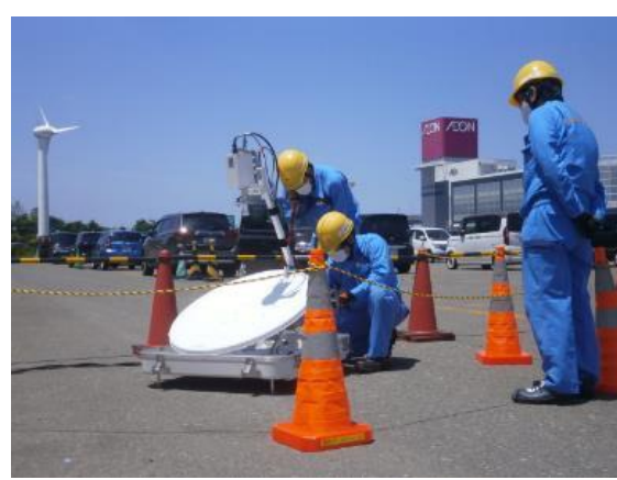
衛星回線を活用した通信回線設置
