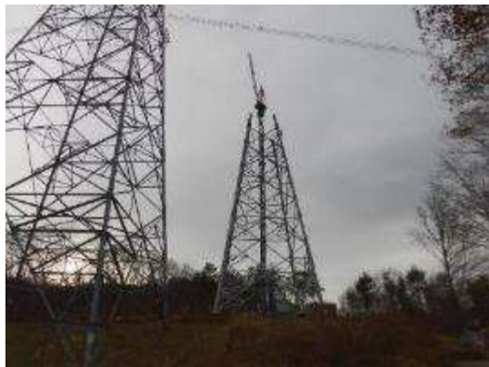
A. 鉄塔組立工事 (No.55-1)
