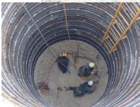
F. 鉄塔基礎工事 (No.139)
