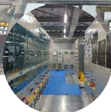
B | 配電盤据付
