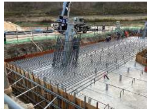
C. 鉄塔基礎工事 (No.76)
