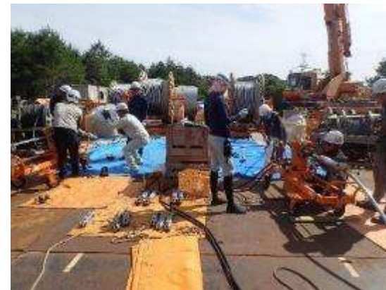
C. 架線工事 (No.88ドラム場)
