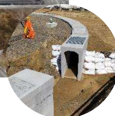
D | 付帯工事
