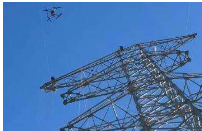
C. 架線工事 (新地アクセス線No.51)
