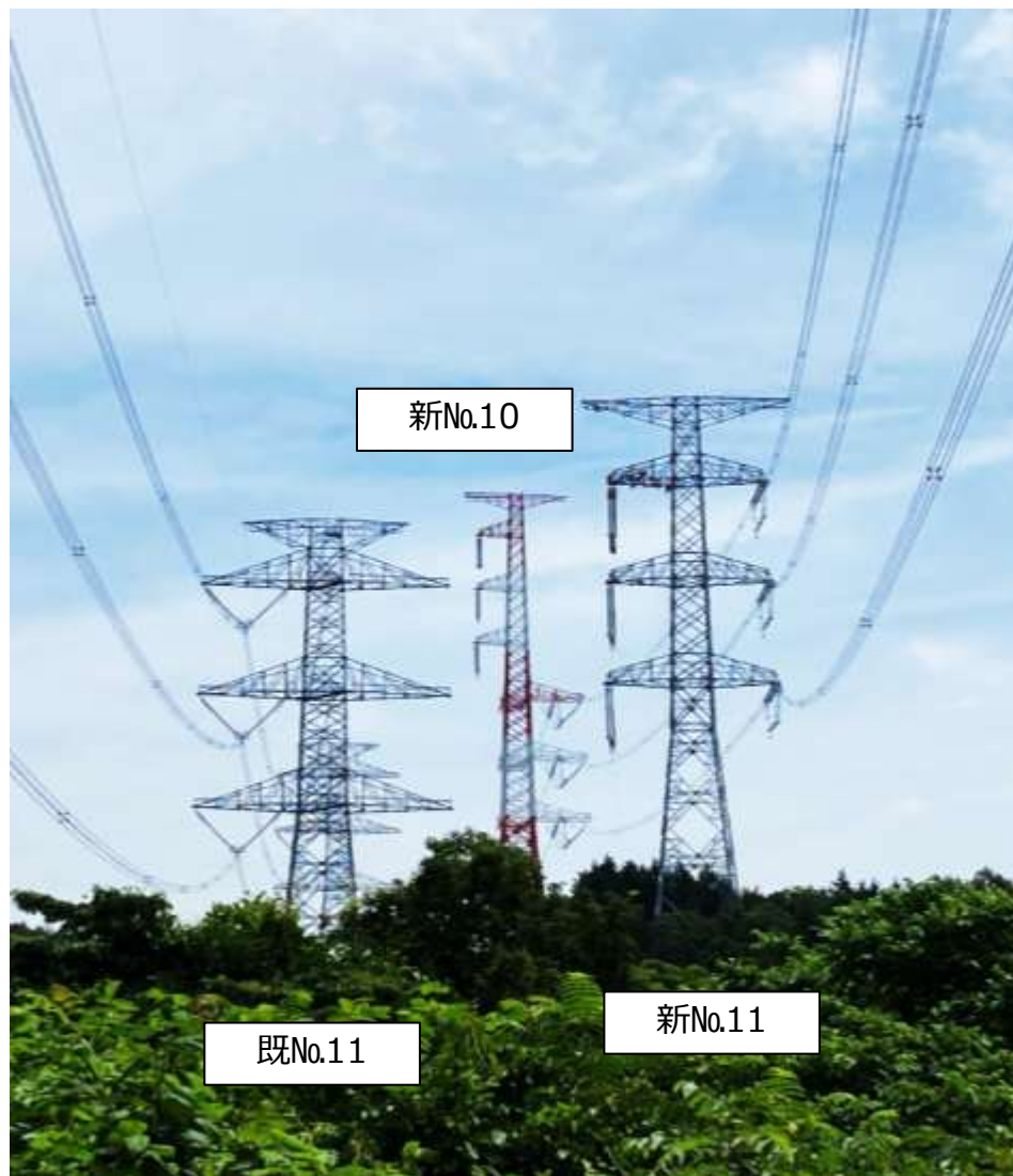
架線工事 (1号線) 完了 : 2025年6月30日 撮影
