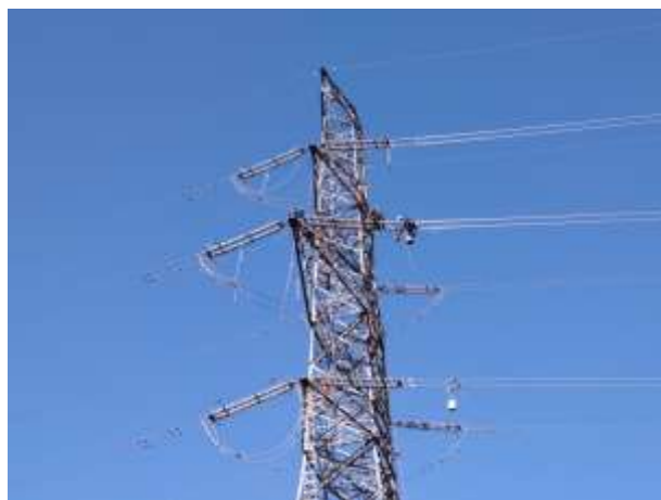
B. No.130_電線取付け作業
