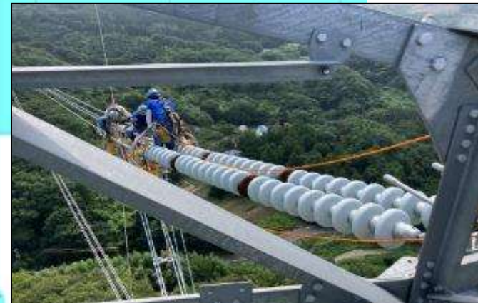
F. 架線工事(No.163)
