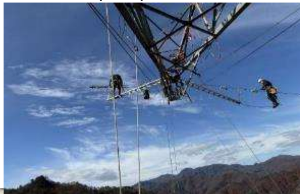
B. 架線工事(No.52)
