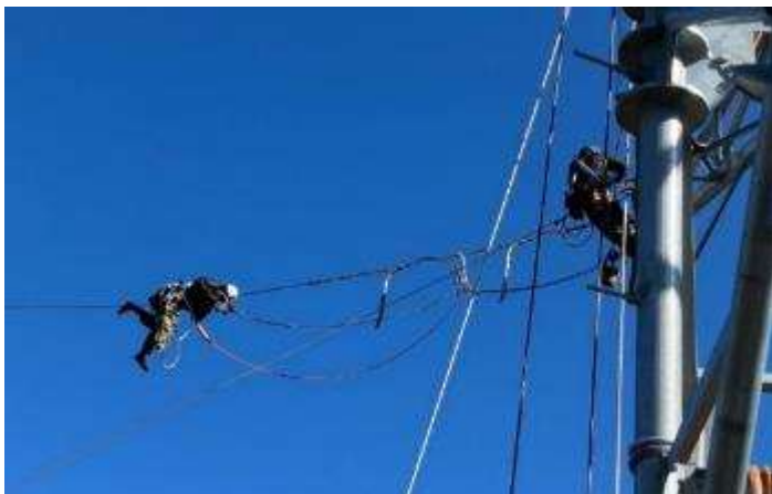
B. 架線工事 (新地アクセス線No.50)
