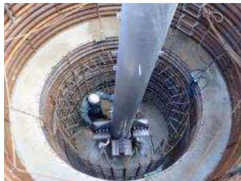
B. 鉄塔基礎工事 (No.31)
