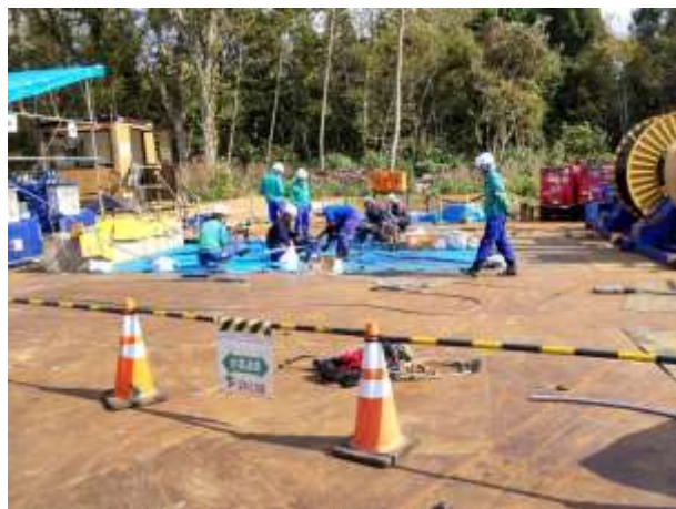
A. No.124_耐張クランプ圧縮作業
