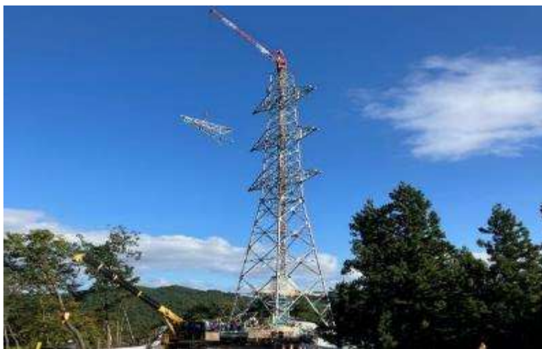
A. 鉄塔組立工事 (新地アクセス線No.50)
