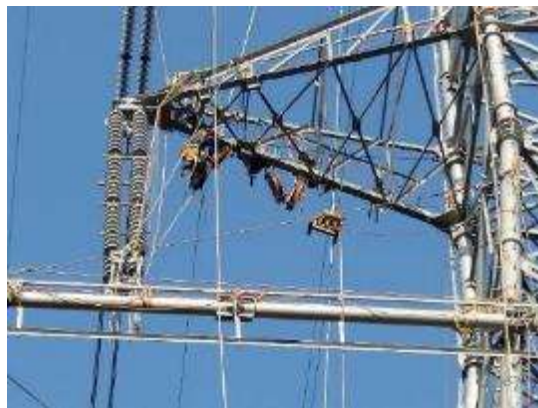
B. 架線工事 (No.66)
