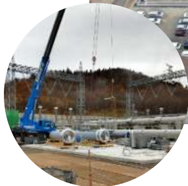
A | GIS据付調整
