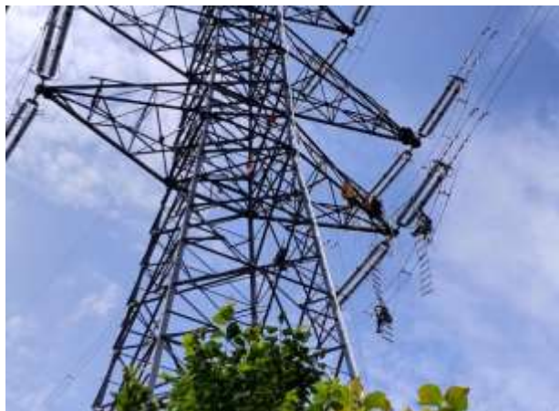
B. No.114_耐張クランプ圧縮作業
