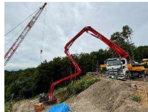
C. 鉄塔基礎工事 (No.60)
