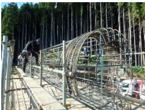
E. 鉄塔基礎工事 (No.120)
