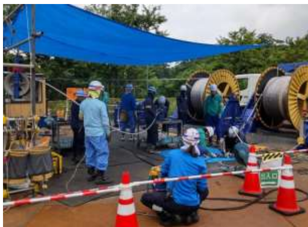
B. No.114_耐張クランプ圧縮作業
