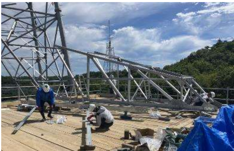
A. 鉄塔組立工事 (常磐南幹線No.1)
