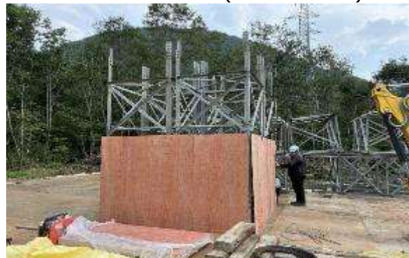
B. 防護鉄柱基礎工事(No.57～No.58)
