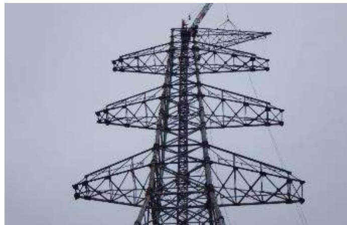
C. 鉄塔組立工事 (新地アクセス線No.52)
