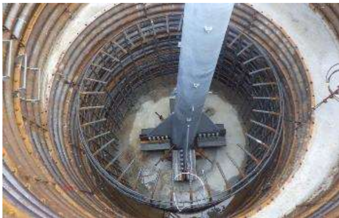
B. 鉄塔基礎工事 (新地アクセス線No.50)
