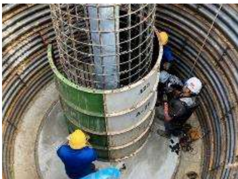
E. 鉄塔基礎工事 (No.120)
