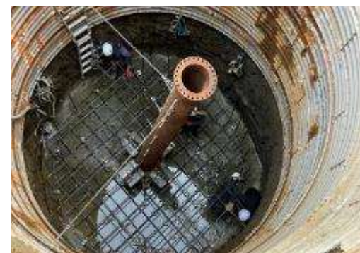
C. 鉄塔基礎工事 (No.62)
