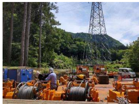
C. No.160 既設電線撤去作業
