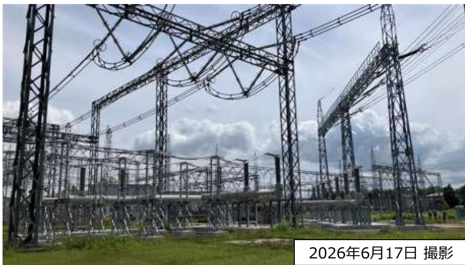
275kV佐久間東幹山線1,2号GIS 組立完了
