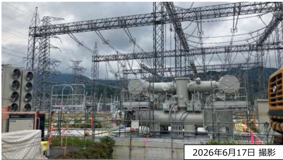
500kV GIS（7号変圧器一次用） 組立作業中
