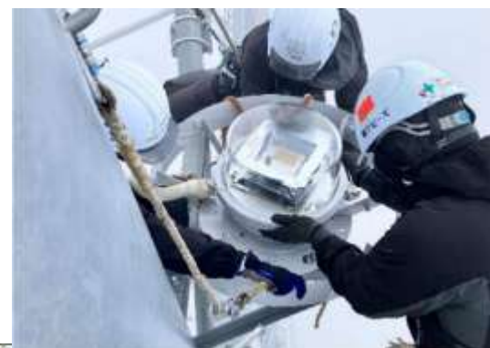
C. 鉄塔付帯工事(No.73航空障害灯)
