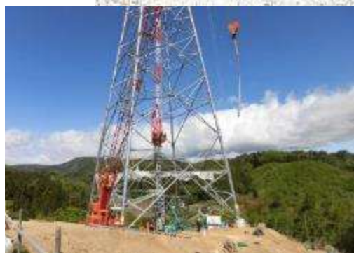
F. 鉄塔組立工事 (No.142)
