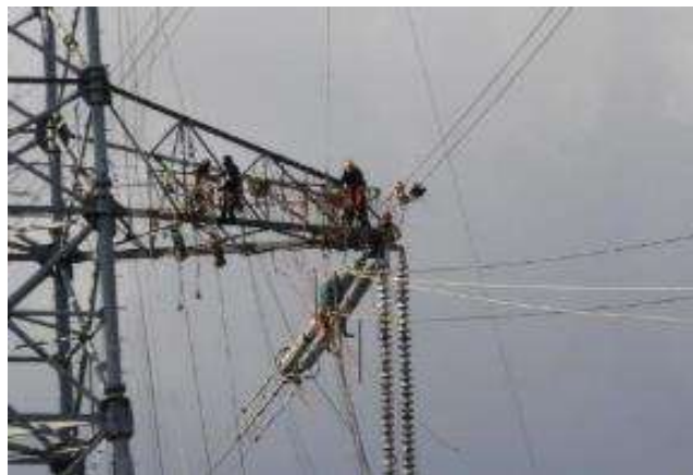
A. 架線工事 (No.54)
