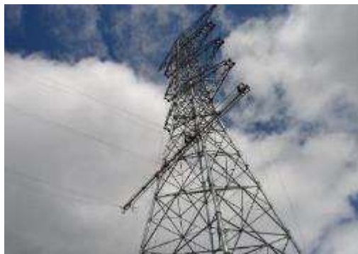
B. 架線工事 (No.27)
