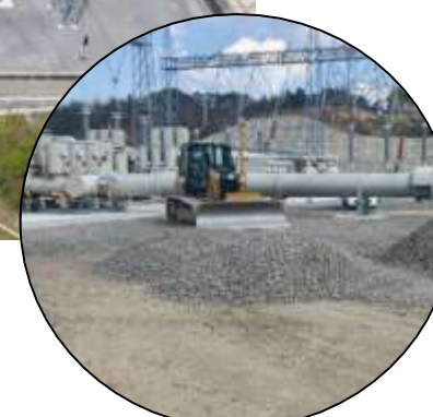
D | 敷碎石工事
