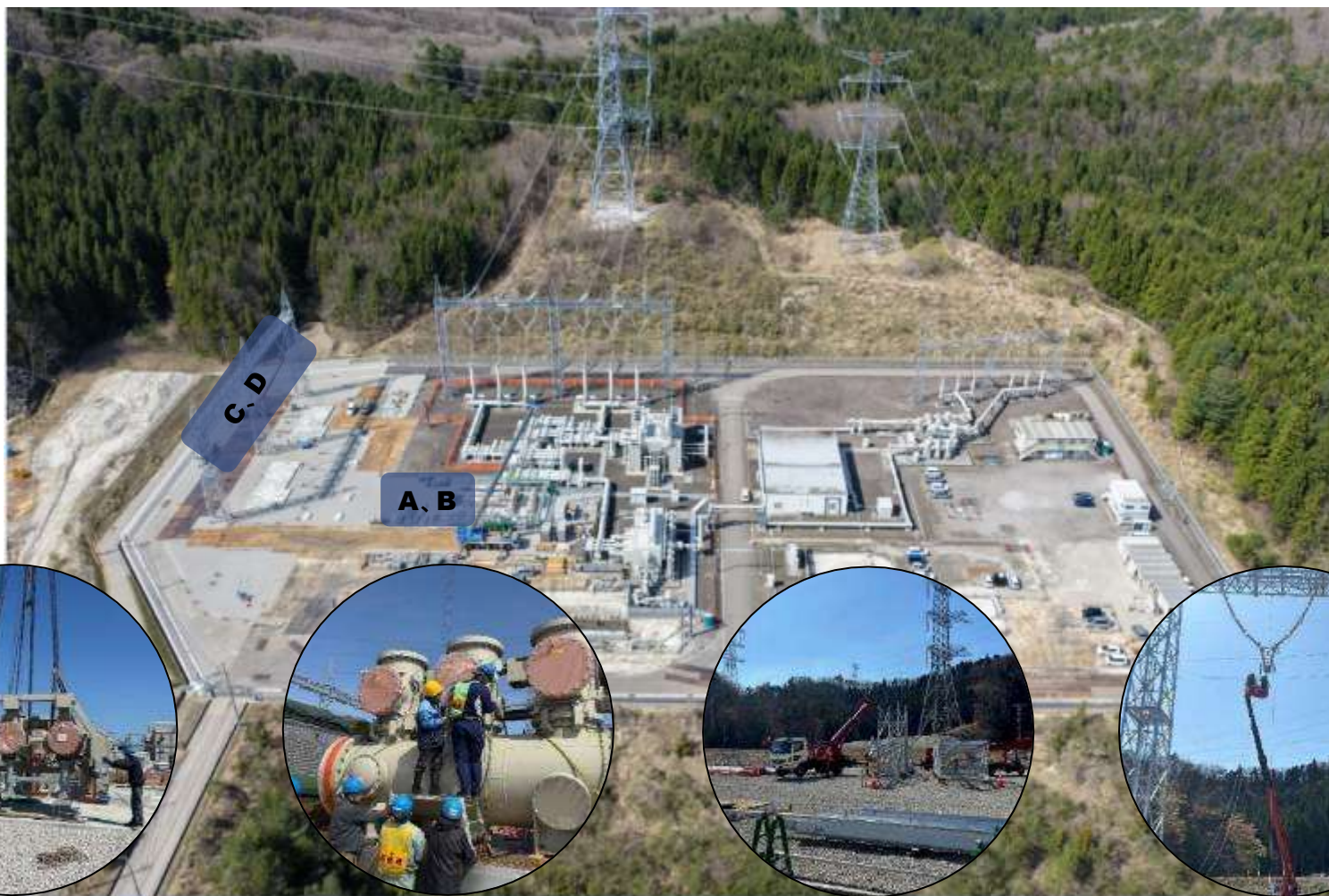
A | GIS据付工事
