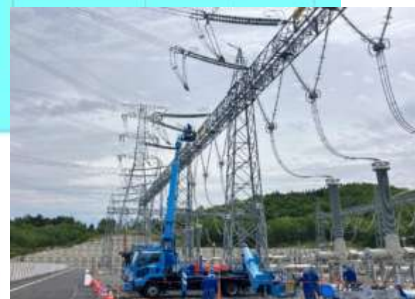
F. 架線工事(宮城丸森開閉所)
