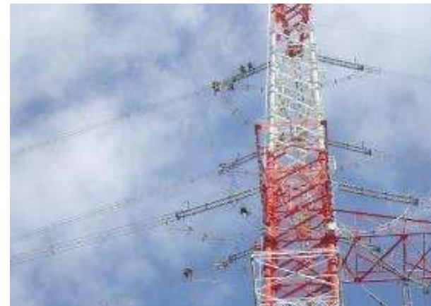
B. 架線工事 (福島幹線山線No.10)
