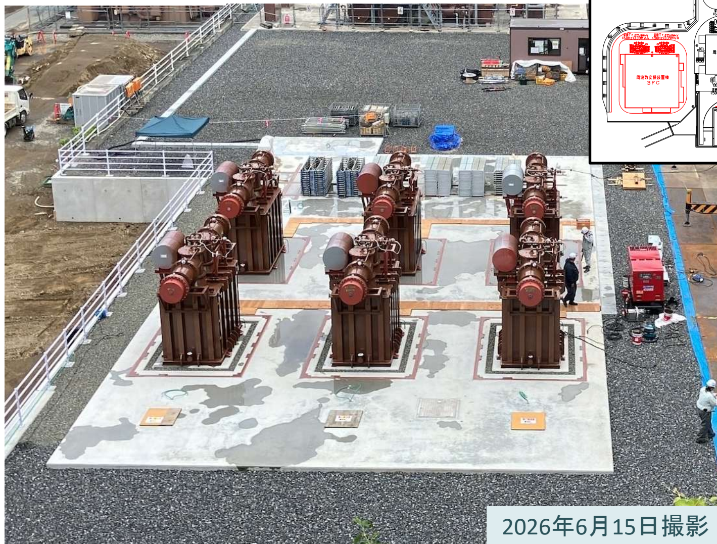
交流フィルタ据付施工中
