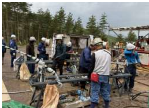
B. 架線工事(No.61)
