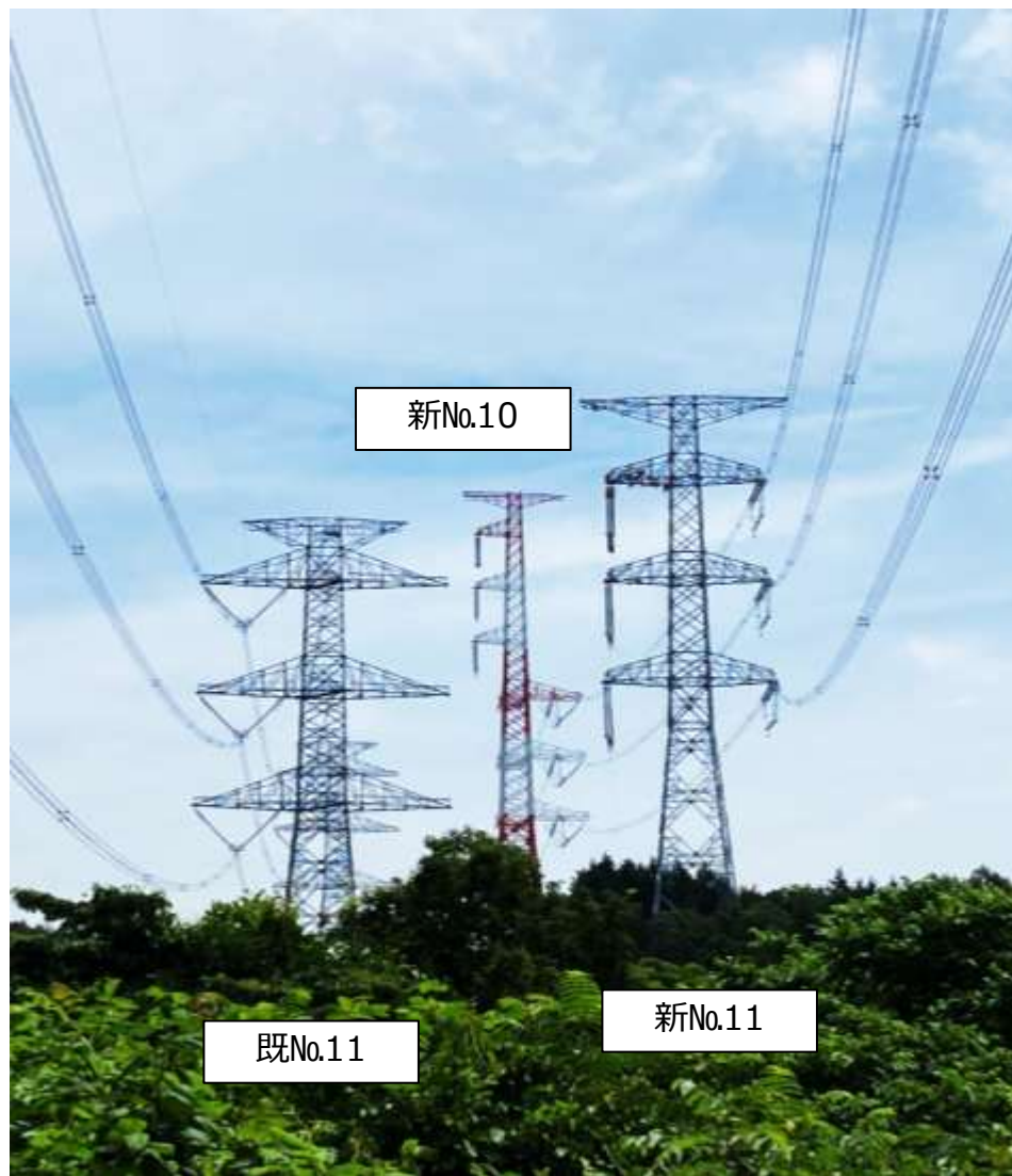
架線工事（1号線）完了：2025年6月30日 撮影
