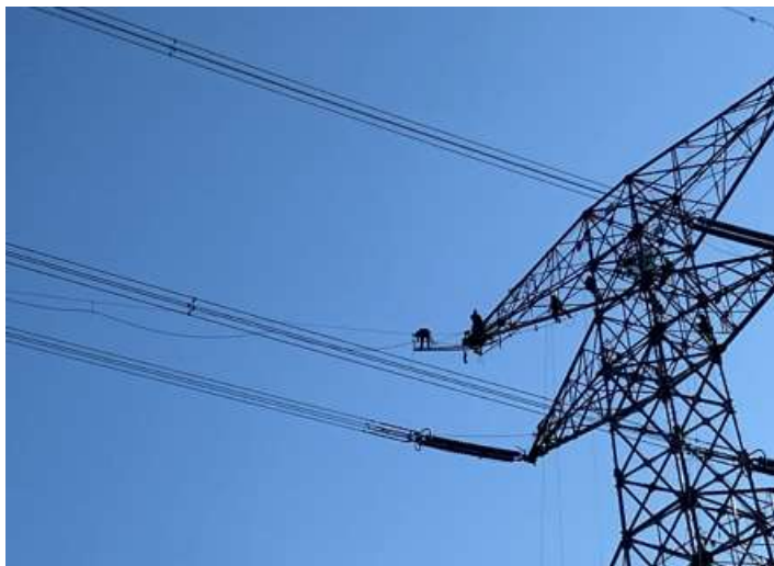
A. 架線工事 (新地アクセス線No.50)
