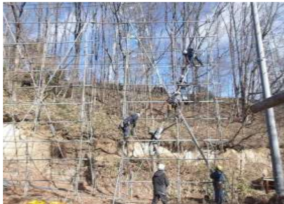
B. 架線工事 (No.55-56防護施設)
