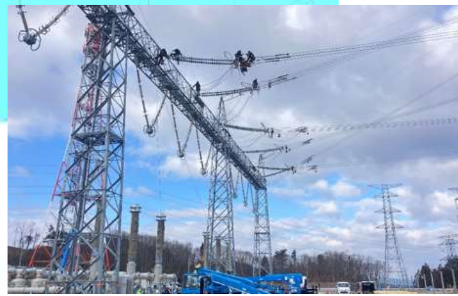
F. 架線工事(宮城丸森開閉所)
