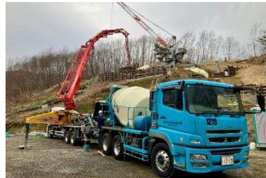
C. 鉄塔基礎工事 (No.73)
