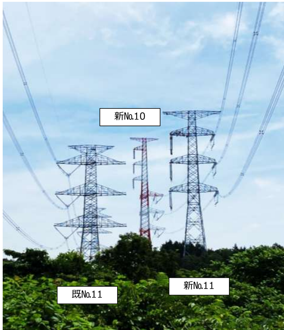
架線工事 (1号線) 完了 : 2025年6月30日 撮影
