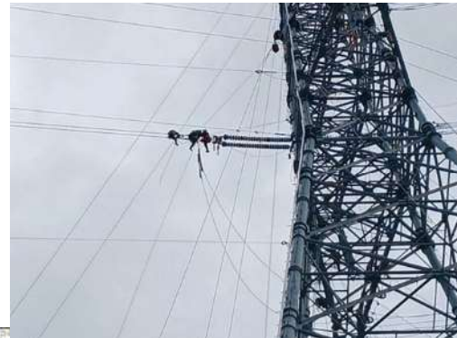
C. 架線工事(No.82)
