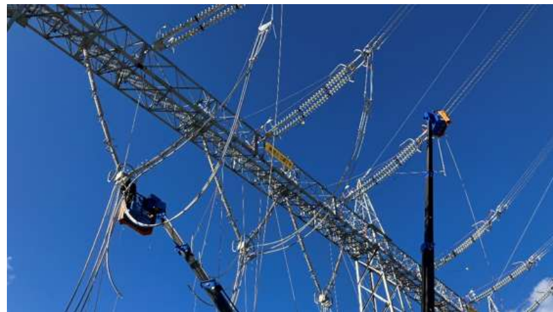
C. 架線工事 (宮城丸森開閉所)
