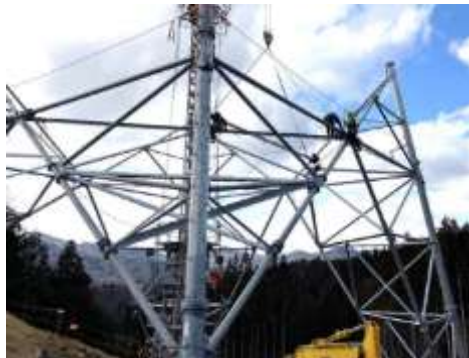
D. 鉄塔組立工事 (No.101)
