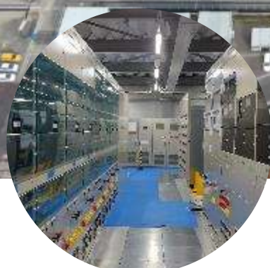
B | 配電盤据付
