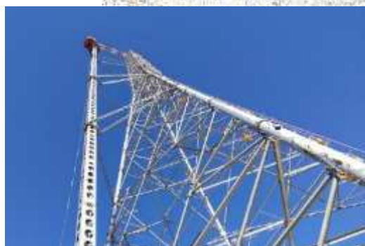
F. 鉄塔組立工事 (No.134)
