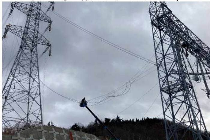
B. 架線工事 (新地アクセス線No.52)
