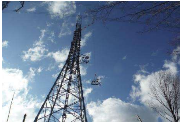
A. 鉄塔組立工事 (No.55-1)
