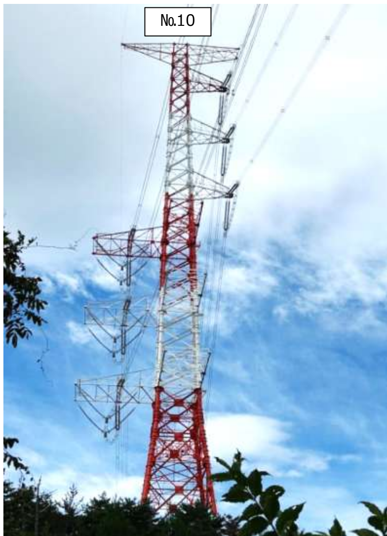
架線工事 (1号線・2号線) 完了 : 2025年9月25日 撮影
