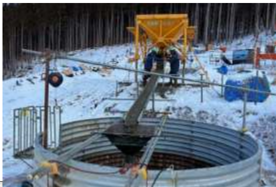
B. 鉄塔基礎工事(No.49)
