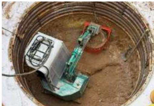
B. 鉄塔基礎工事 (No.28)
