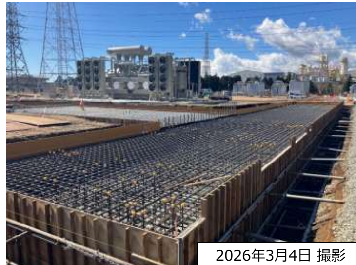
500kV GIS基礎工事実施中
