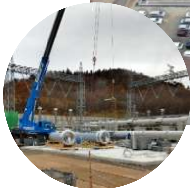
A | GIS据付調整
