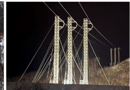
紋別東線 仮復旧状況
