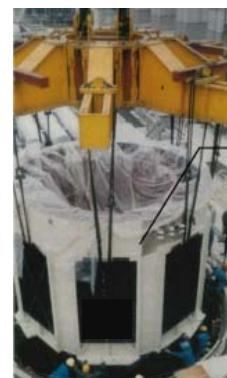
■同期調相機写真（固定子吊込み）
