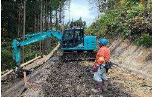
A. 造成工事(No.18)
