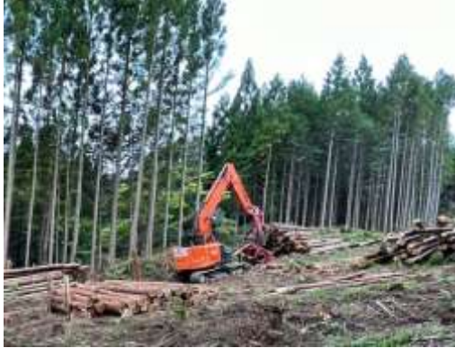
A. 伐採工事 (No.8)
