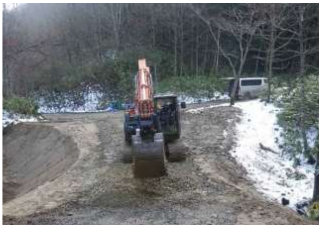
【補修後】 中野湯ノ沢線林道 (2023年11月28日撮影)
