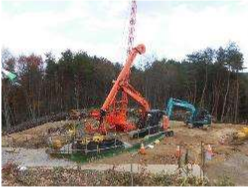
A. 鉄塔基礎工事 (No.55)
