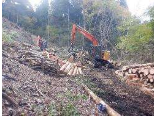
B. 伐採工事 (No.30)
