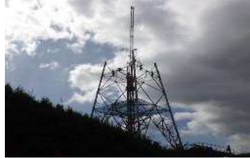
B. 鉄塔組立工事(No.31)
