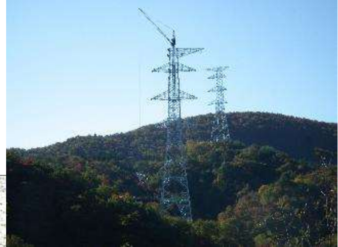
C. 鉄塔組立工事(No.60)
