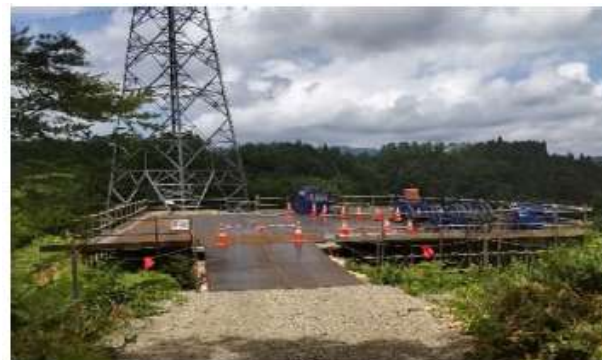
C. 架線工事 (No.71) (電線緊線)
