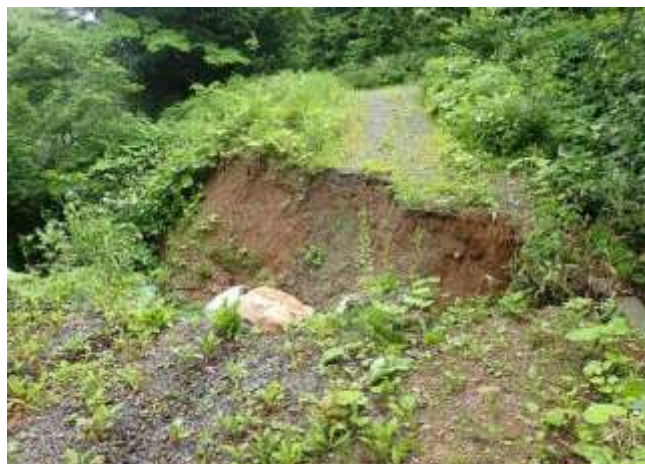
【補修前】 中野湯ノ沢線林道 (2023年7月6日撮影)
