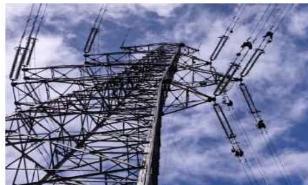
B. 架線工事 (No.25) (吊金展開)
