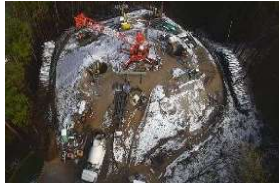
B. 鉄塔基礎工事 (No.56)
