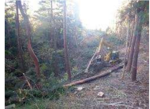
D. 伐採工事 (No.102)
