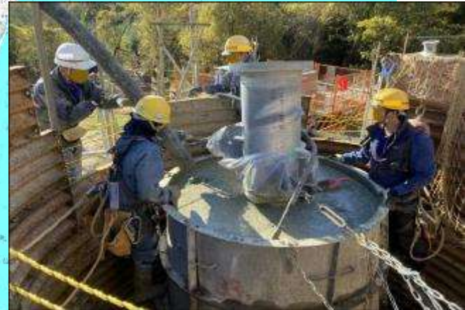
F. 鉄塔基礎工事(No.168)
