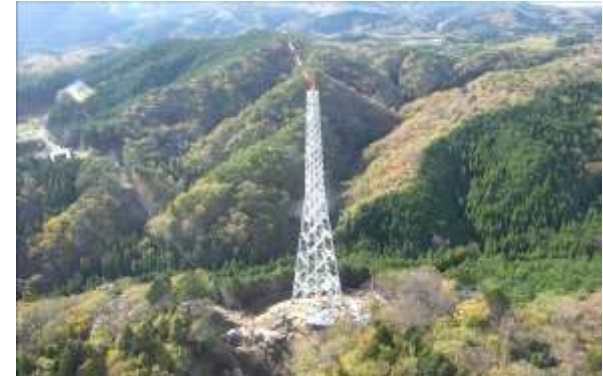
C. 鉄塔組立工事 (No.76)
