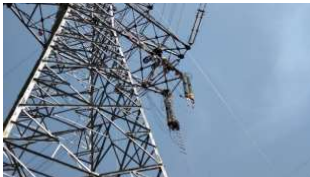
B. 架線工事 (No.25 ドラム場) (電線延線)
