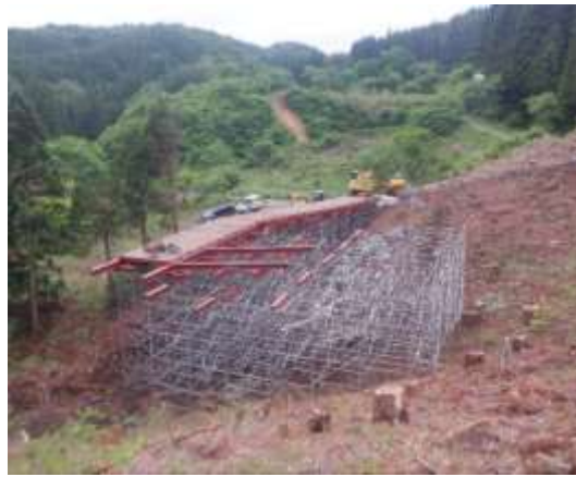
B. 仮設造成工事 (No.76)
