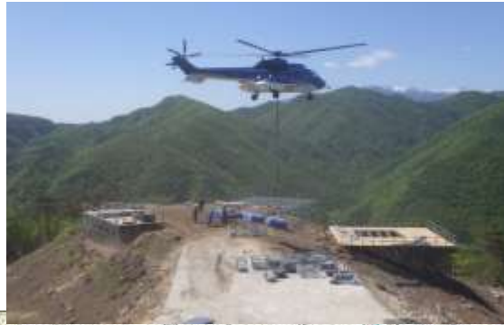
B. 基礎工事(No.56)
