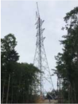
A. 鉄塔組立工事 (No.72)
