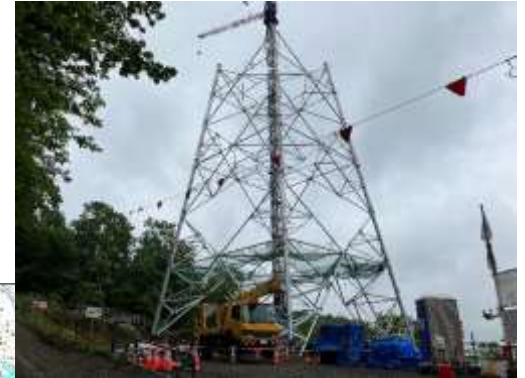
C. 組立工事(No.63)
