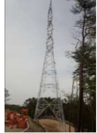
D. 鉄塔組立工事 (No.82)
