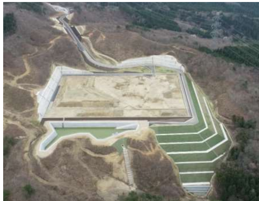
全景 (北側より撮影)
