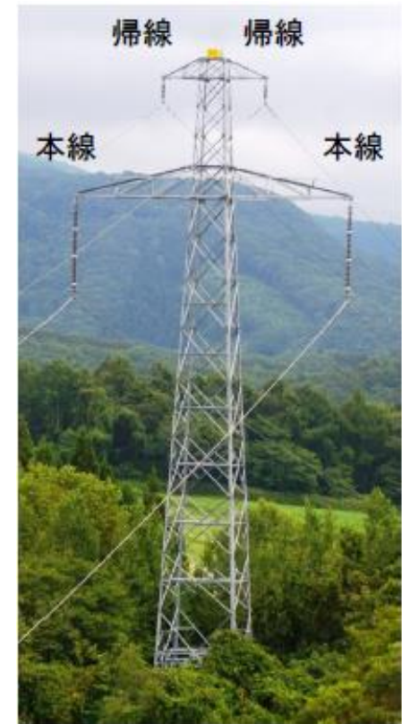
旧北本架空線鉄塔
