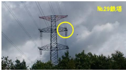
地震の揺れにより①ジャンパー線が②架線金物に接近
